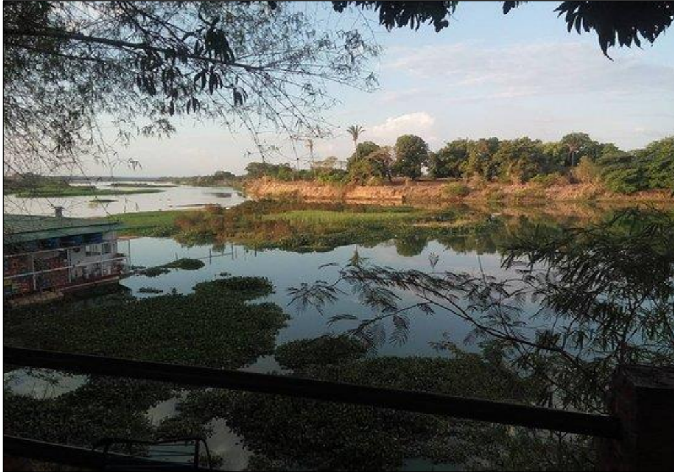
Figura 3 - Degradação e assoreamento da margem esquerda do Rio Poti
