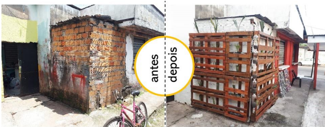
Figura 4 – Fachada de restaurante localizado na esquina da entrada principal do centro comercial do Conjunto Jardim Maguari – antes e depois da intervenção urbana.
