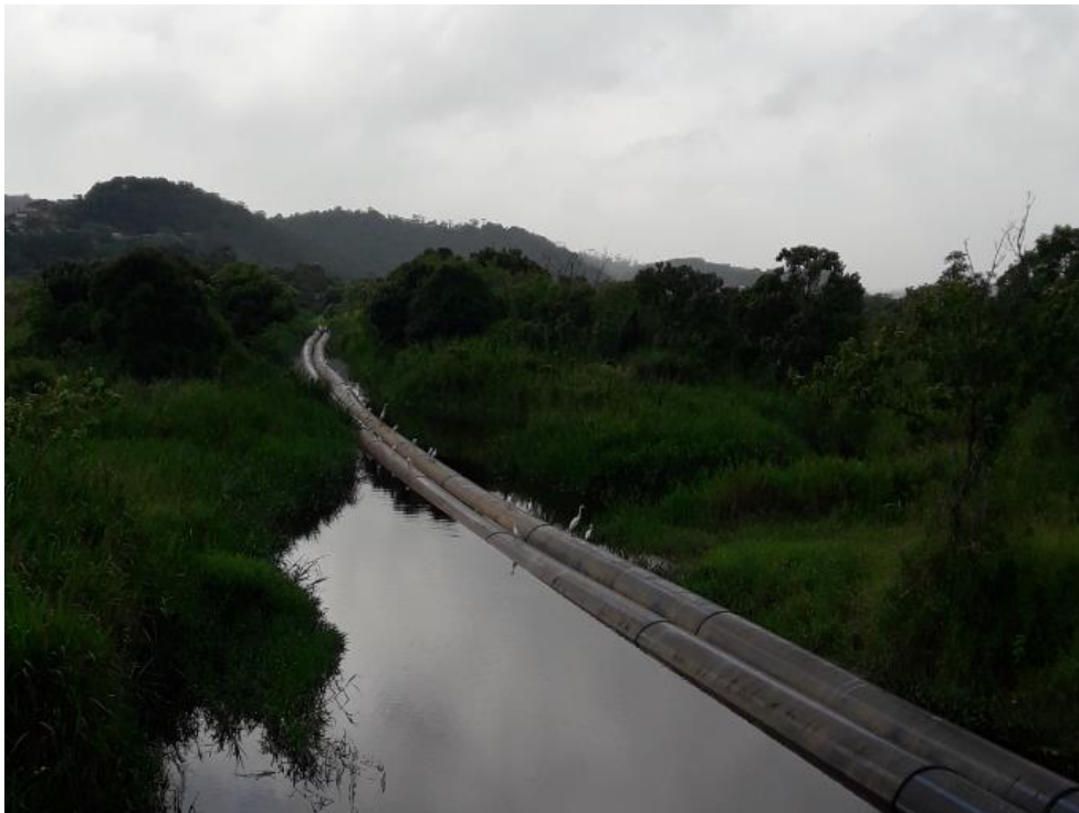
Figura 2. Registro dos garças e biguás em cima da tubulação se alimentando de peixes mortos ou moribundos
