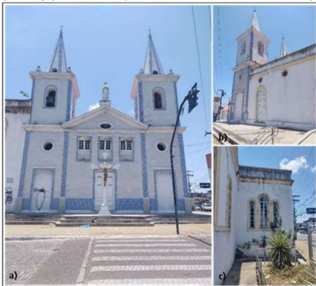
Figura 6 – Igreja N. S. da Conceição da Prainha. a) Fachada, b) e c) Laterais da Igreja
