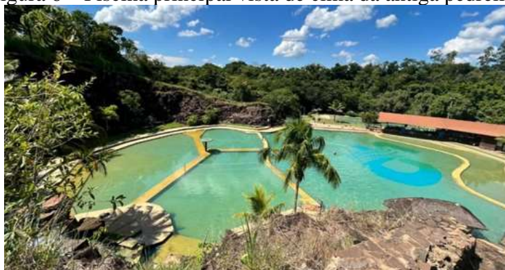
Figura 6 – Piscina principal vista de cima da antiga pedreira.
