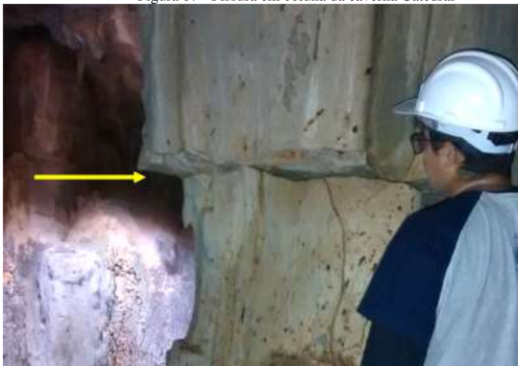
Figura 07 - Fissura em coluna da caverna Cathedral
