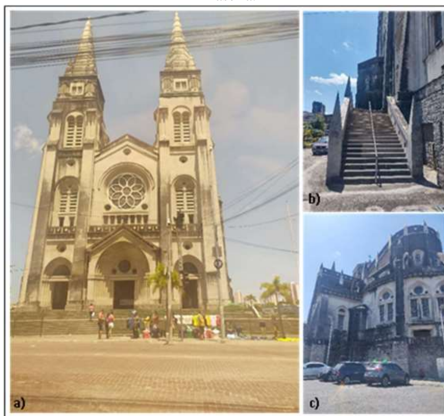
Figura 7 – Catedral Metropolitana de Fortaleza. a) Fachada, b) Entrada Lateral, c) Traseira.
