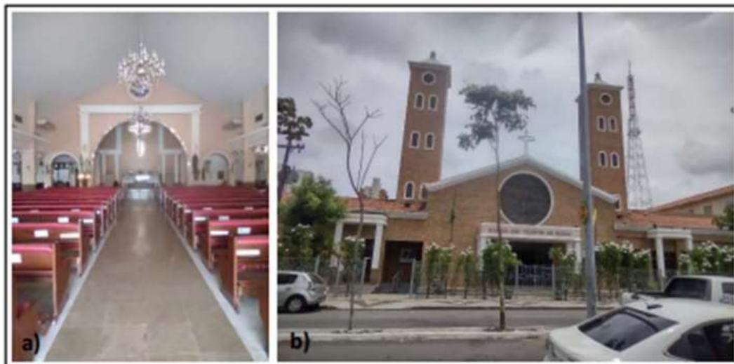
Figura 2 – Igreja São Vicente de Paulo. a) Nave Principal, b) Fachada.
