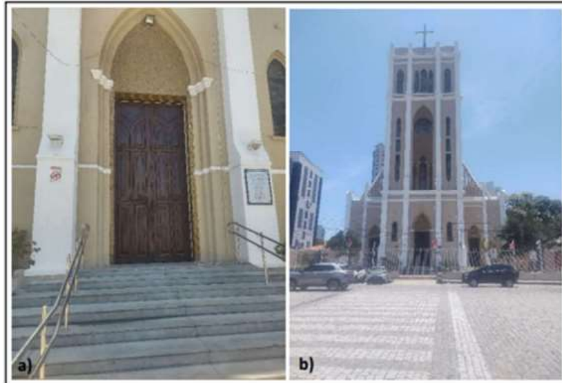
Figura 4 – Igreja Cristo Rei. a) Porta Principal, b) Fachada.
