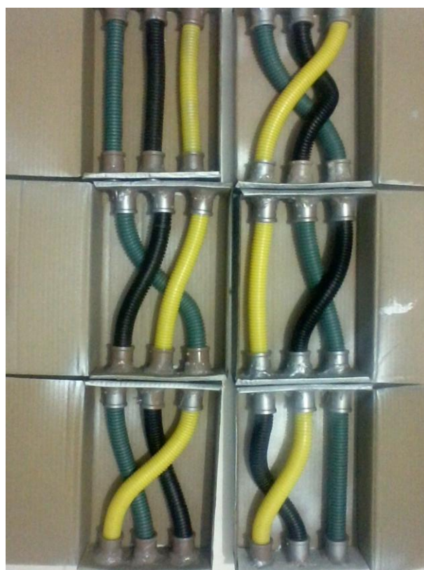
Figura 10 – Caixas com conduítes fixados
